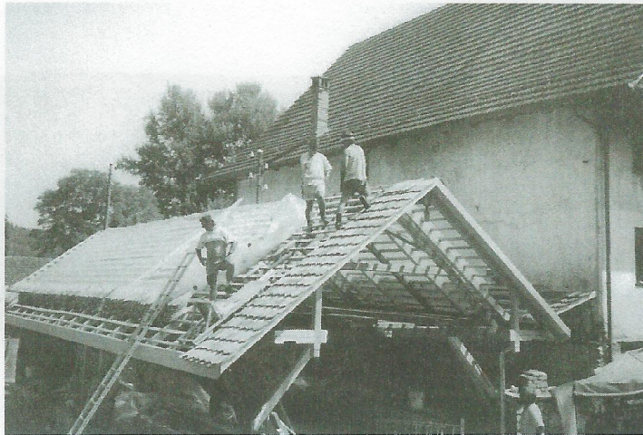
Beginn der Neudeckung des Sägereidaches mit Schindeln und alten Handstrichziegeln.
