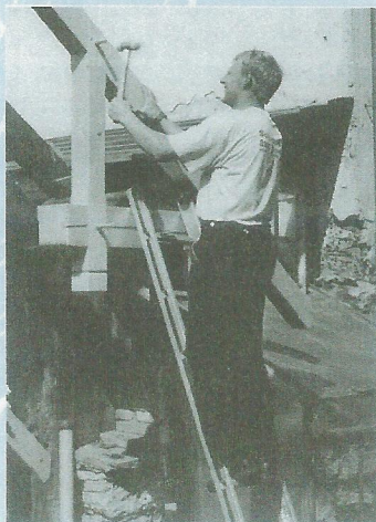
Der Zimmermann Peter Gäumann befestigt das "Züri Vieri" mit einem letzten Hammerschlag auf den Holznagel.
