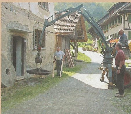
Kari Scherrer hievt mit einem Helfer und Franz Fürling das begehrte Kegelzahnrad mit seinem Kranwagen vorsichtig in den Mahlraum
